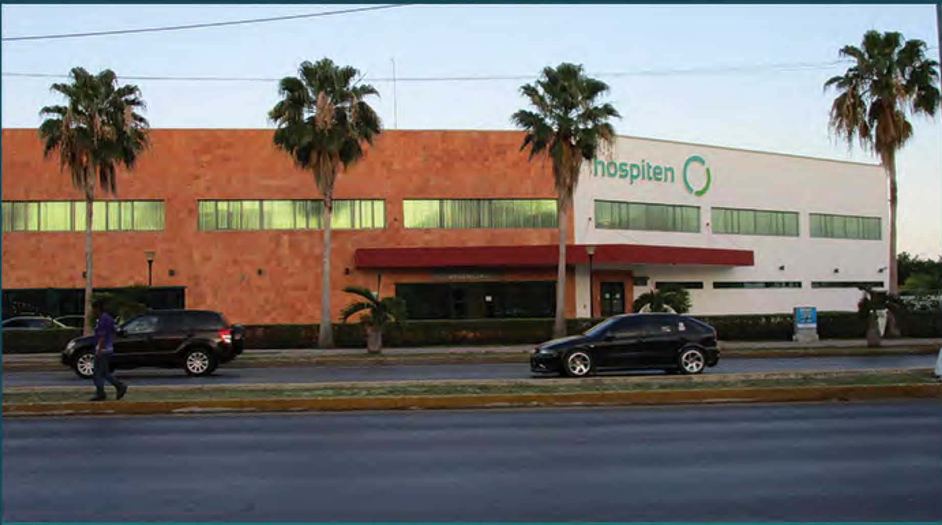
Hospital Hospiten Impermeabilización con Poliurea
