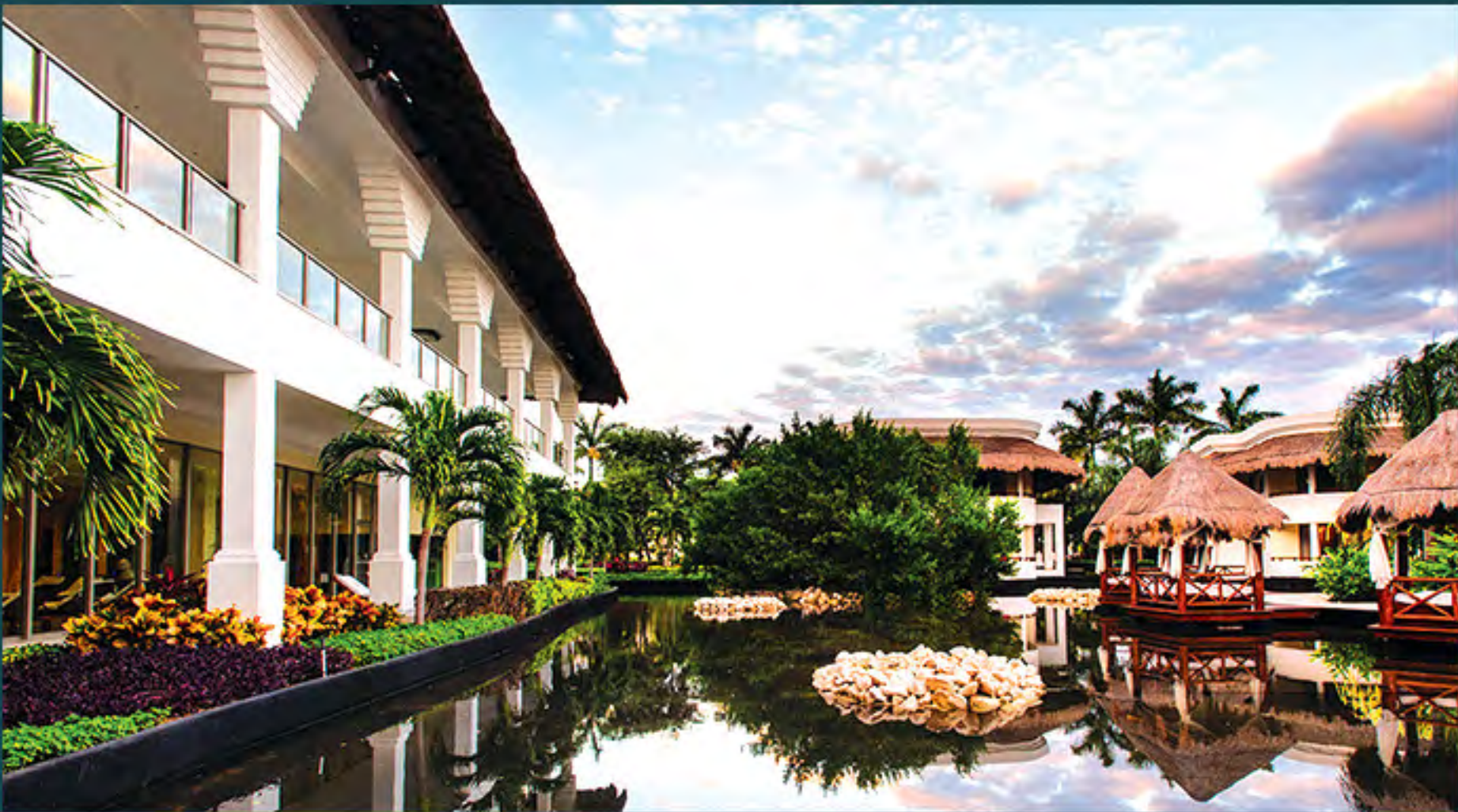
Hotel Princess Impermeabilización, Poliurea
