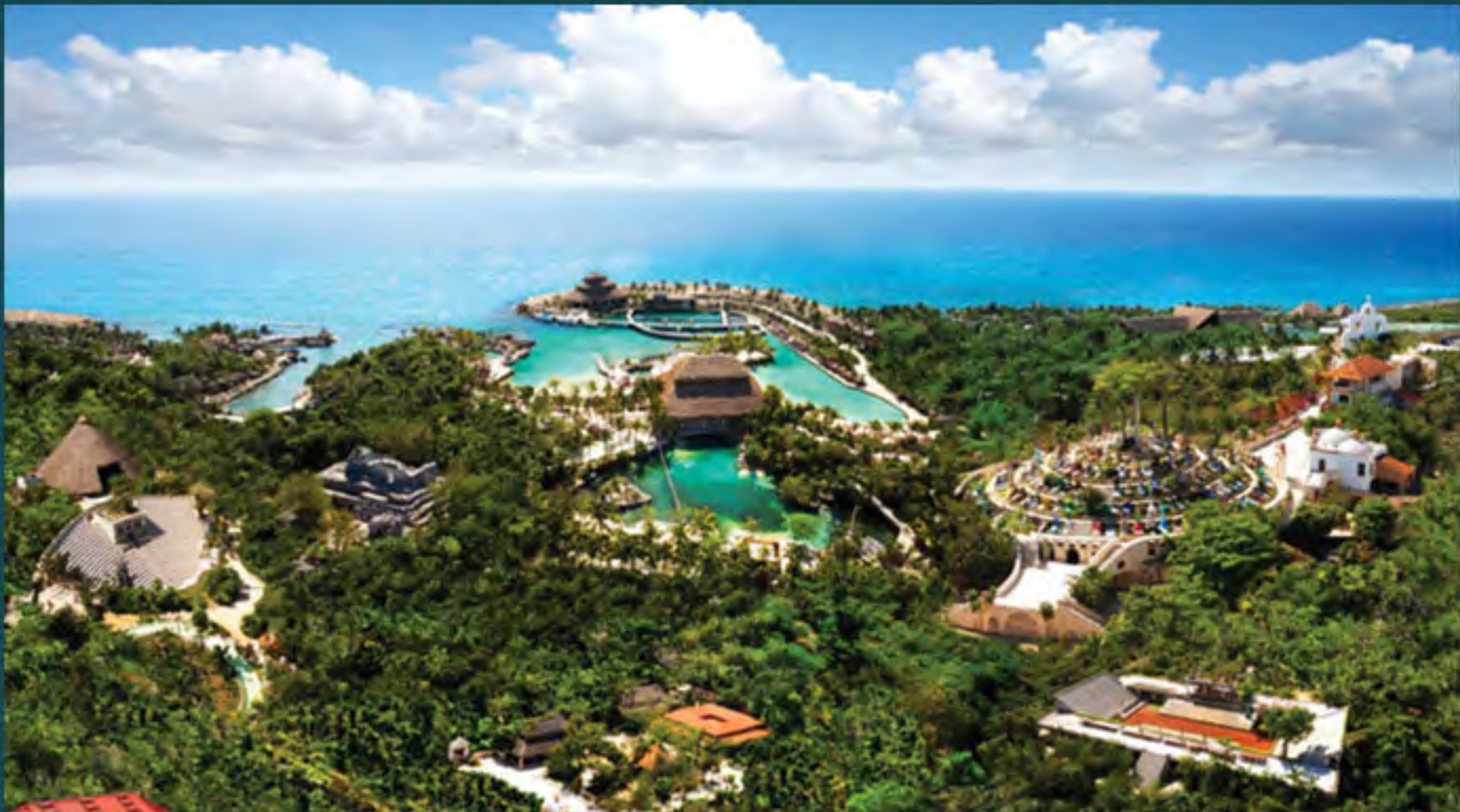
Parque Xcaret Impermeabilización, Aislamiento térmico con Poliurea
